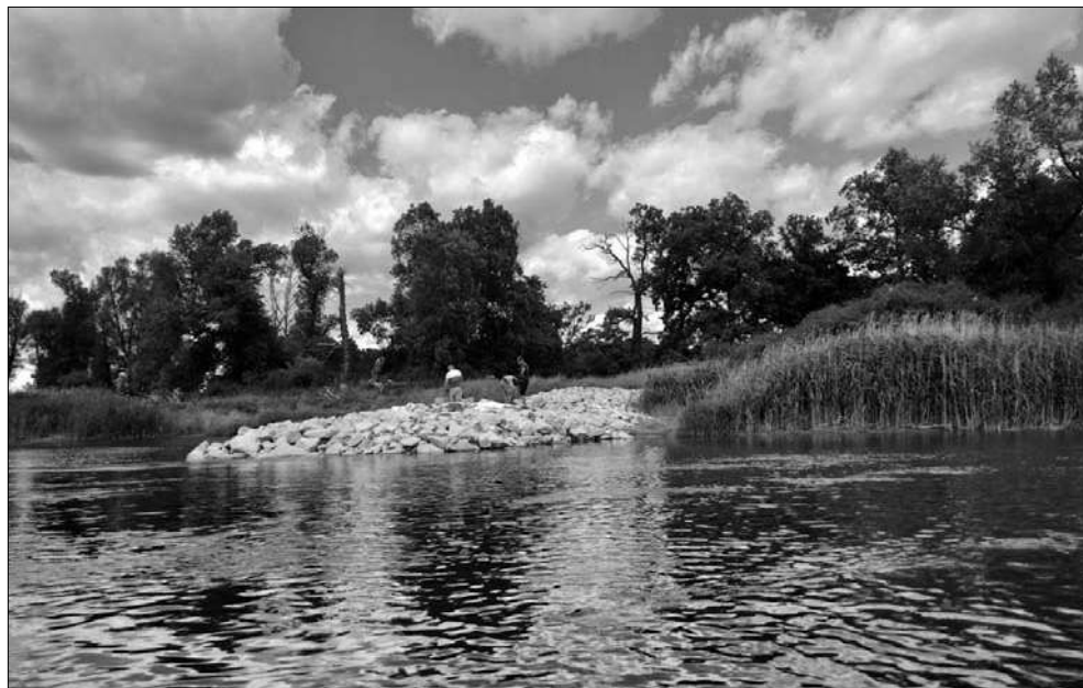
Kamienowanie Odry Śródkowej – ostrogi, czerwiec br.
