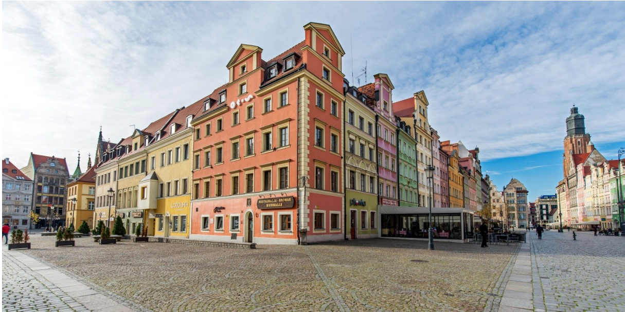
Budynek siedziby OKiS, ul. Rynek –Ratusz 24, Wrocław
